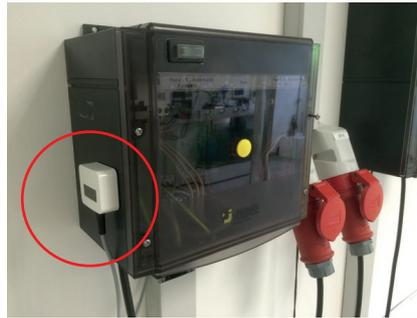
Störmeldungen, wie Hochwasser, Wasserdetektion oder Pumpenausfall werden im Ernstfall an das Gateway gefunkt. Ob dies weitere Ereignisse im Haus auslöst oder nur eine Alarmmeldung auf das Smartphone weitergegeben wird, entscheidet der Betreiber ganz allein.
